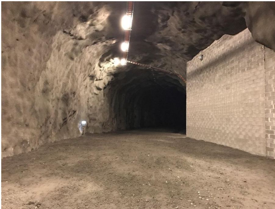
Kuva 5.2, Olemassa oleva ilmanvaihtotunneli, oikealla tekninen tila NK3
